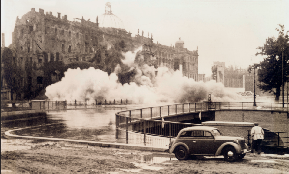
8. Sprengung des Schlosses, 1950
