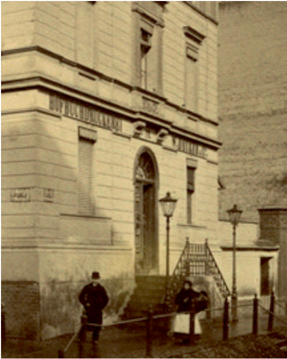
Wejście główne do budynku
