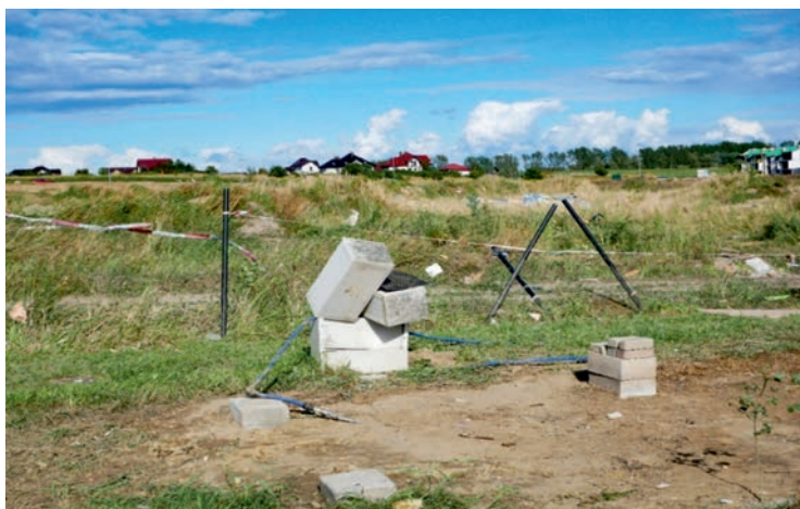
Ryc. 9. Zniszczona skrzynka elektryczna oraz część ogrodzenia po przejściu tornada. Grafika własna
