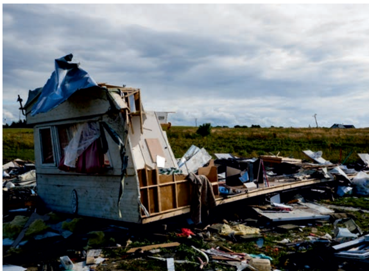
Ryc. 8. Zniszczony domek holenderski po przejściu trąby powietrznej. Grafika własna
