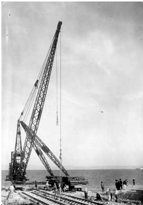
Ryc. 4. Budowa portu morskiego w Gdyni – pracujący żuraw podczas budowy portu w Gdyni (Źródło: Narodowe Archiwum Cyfrowe)
