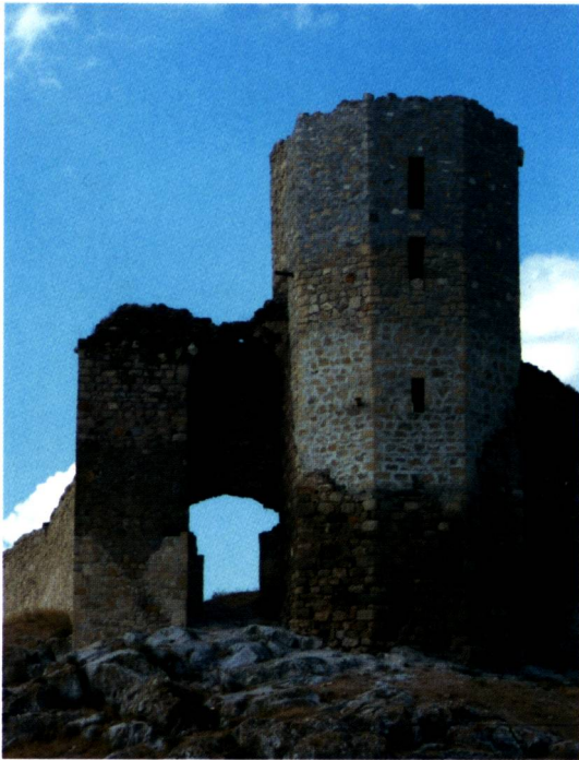
4. Enisala – brama południowa i sąsiednia baszta sześcioboczna (3 ćwierć XIV w.?).
