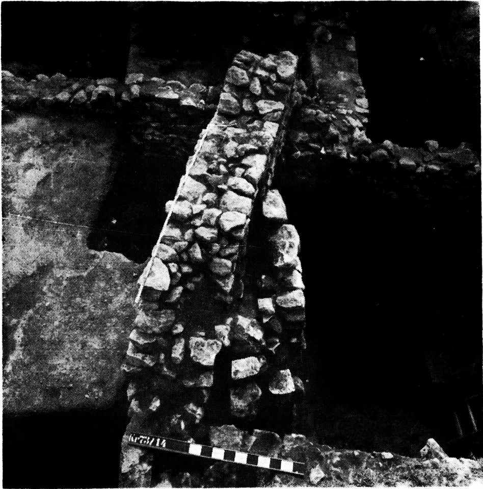
Abb. 12. Südostecke eines Steinhauses aus Periode D2 über der Nordmauer von Objekt XXXII
