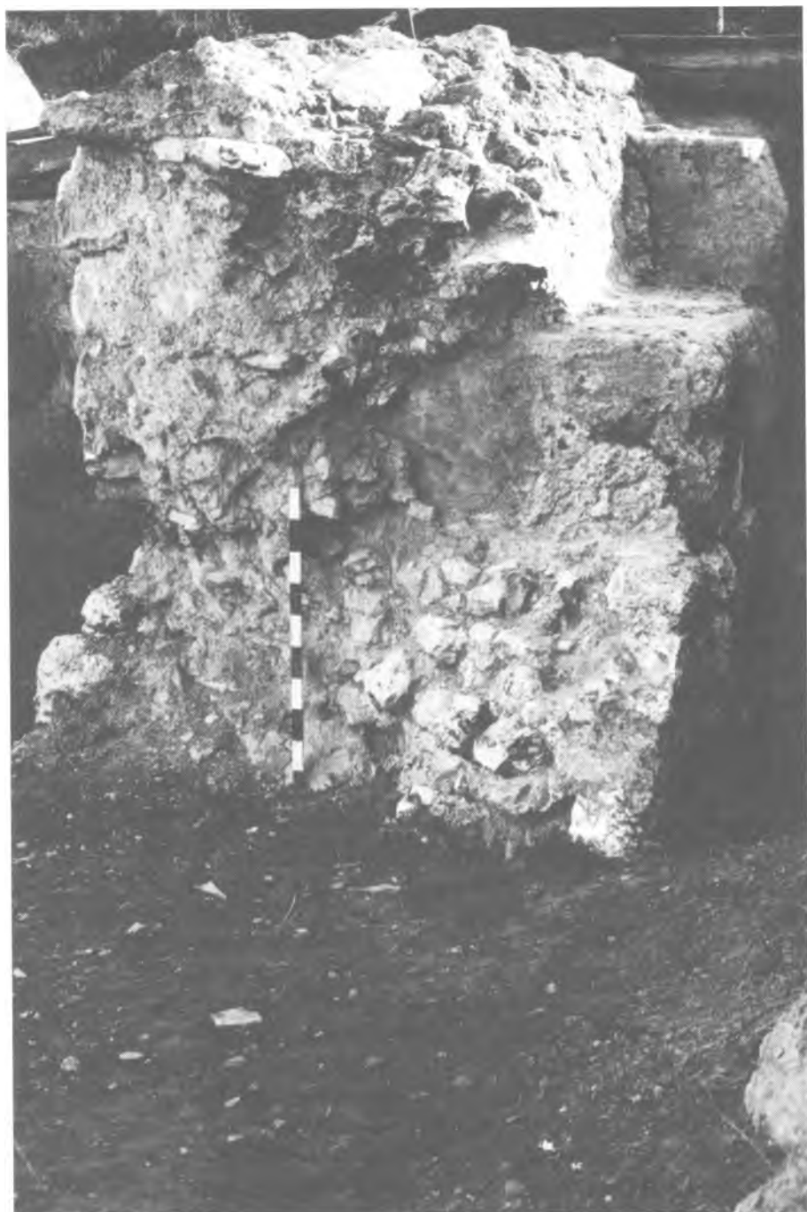
Рис. 3. Разрушенная стена на южном участке лагерной стены
