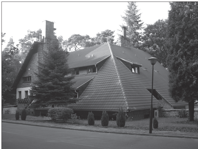
Fot. 15. Gościniec „Lizawka” (2016) – obiekt jest sukcesywnie odnawiany. W październiku 2016 zostanie tu otwarty trzygwiazdkowy hotel i restauracja z tradycyjną kuchnią polską i wielkopolską (specjalnością będzie, tak jak w latach 70., dziczyzna). Fot. W. Bryl-Roman.
