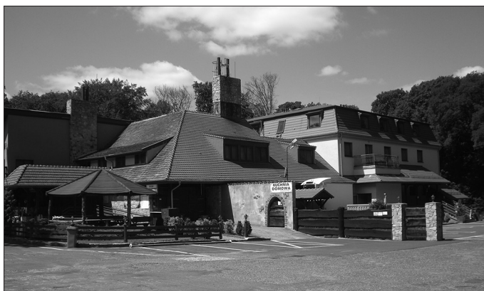
Fot. 18. Gościniec „Ostęp” (2016) – niefortunna rozbudowa obiektu zniszczyła wymowę oryginalnej koncepcji architektonicznej.
