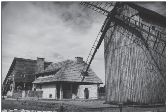
Fot. 12. Gościniec „Tośtoki” w Koszutach k. Środy Wlkp., w sąsiedztwie starego wiatraka. Obiekt obecnie częściowo wyremontowany po pożarze w 2008 r., nieczynny, wystawiony na sprzedaż. Pobliskie wiatraki – niegdyś atrakcja regionu – popadają w ruinę.
