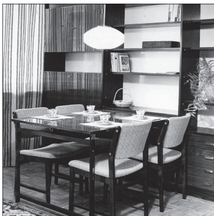
Fot. 5–6. Wielofunkcyjne meblościanki, począwszy od prototypowego rozwiązania „meblościanki Kowalskich”, były kluczowym elementem systemów wyposażenia wnętrz z wielkiej płyty: chowany blat stołu czy łóżko po złożeniu oddawały przestrzeń, niwelując podział na strefy „dzienne” i „nocne” mieszkania.
