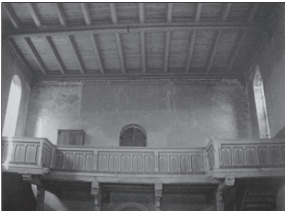
Il. 13. Wnętrze kościoła z emporą muzyczną; fot. z 2006 r. B. Krzyślak
