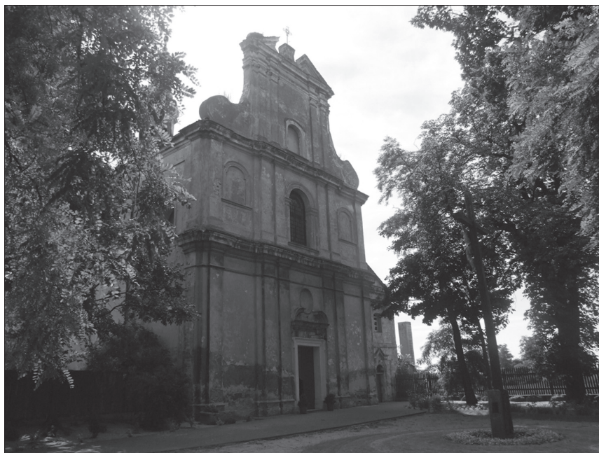
Chocz, kościół poreformacki pw. św. Michała Archaniola, widok na fasadę od zachodu, fot. Monika Dąbkowska, 2009 r.
