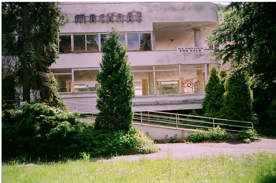
Fot. 3. Dom uzdrowiskowy Machnáč – widok od strony wejścia (fot. Marta Žilková)
