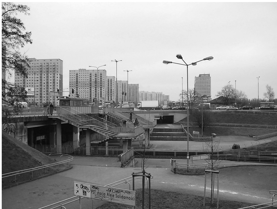
Fot. 2. Poznański Szybki Tramwaj cieszy się dużą popularnością mimo znacznego oddalenia od zabudowy oraz konieczności pokonania licznych schodów lub pochylni (fot. Jędrzej Gadziński)
