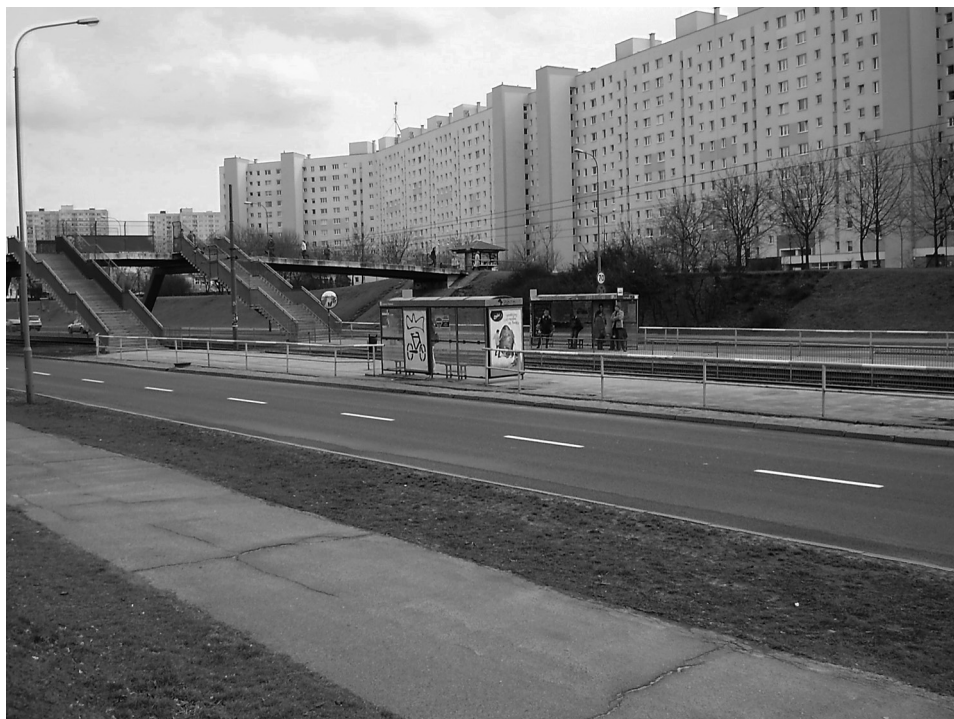
Fot. 1. Dojście do przystanku tramwajowego na Górnym Tarasie Rataj prowadzi po kładce nad jezdnią i bardzo długimi schodami (fot. Jędrzej Gadziński)
