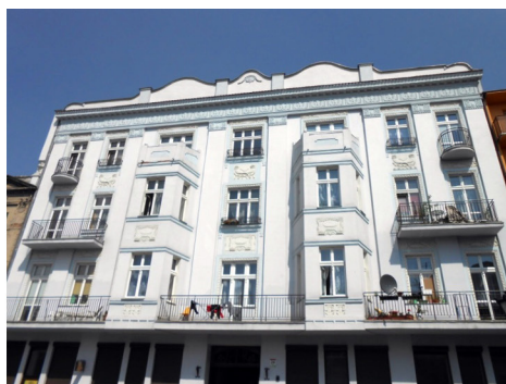
Fot. 6. Kamienica frontowa ul. Cyganka 24 Źródło: Szajerska (2018).
