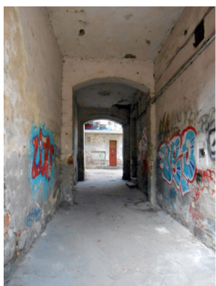
Fot. 11. Przejście na podwórze przy ul. 3 Maja 16 Źródło: Szajerska (2018).
