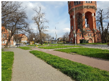
Ryc. 12. Droga dla pieszych i rowerów przy wieży ciśnień (9) Źródło: opracowanie własne.
