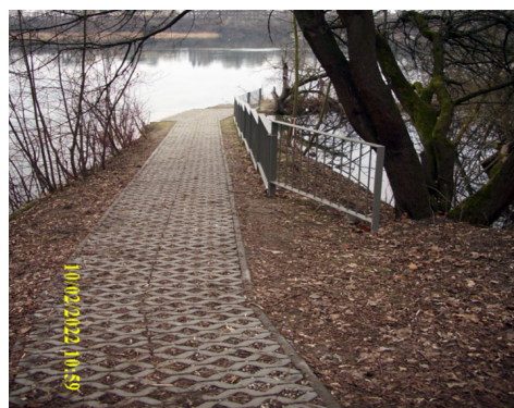
Fot. 9. Utwardzone i wykonane pomosty Źródło: fotografia własna.
