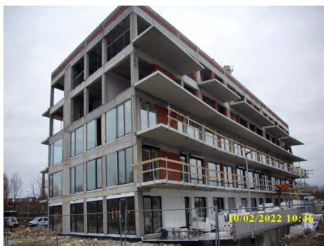
Fot. 4. Rozpoczęta budowa bloku mieszkalnego Nowe Piastowskie, widok od strony parkingu Źródło: fotografia własna.
