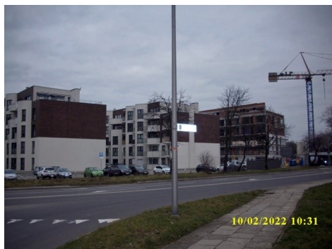
Fot. 3. Rozpoczęta budowa bloku mieszkalnego Nowe Piastowskie, widok od strony ulicy Rejtana Źródło: fotografia własna.
