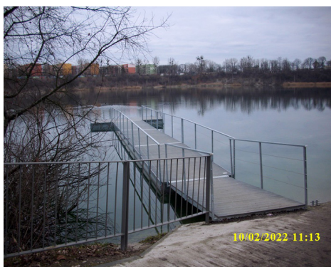
Fot. 10. Utwardzone i wykonane pomosty Źródło: fotografia własna.
