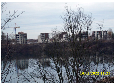
Fot. 2. Widok na osiedle Piastowskie od strony Kamionki Piast oraz rozpoczęta budowa bloku Nowe Piastowskie (blok przy żurawiu) Źródło: fotografia własna.
