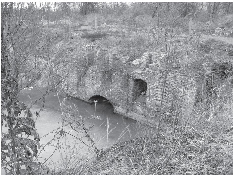
Fot. 4. Fragmenty fundamentów i piwnic renesansowych kamienic odkopanych pod nową zabudowę (fot. Beata Frydryczak).
