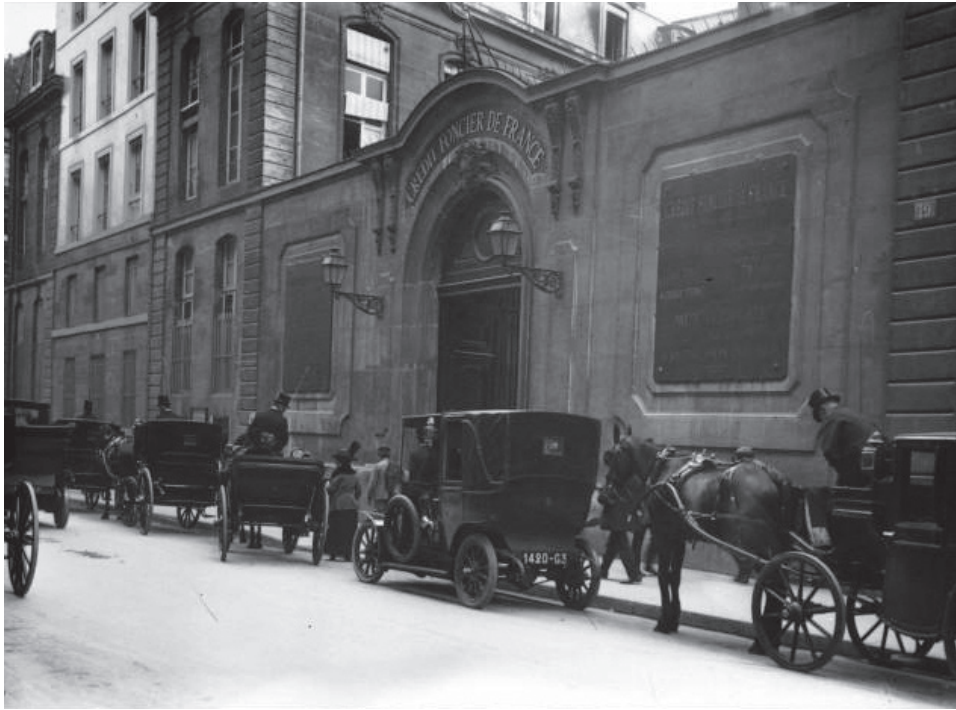
Figure 4. The headquarters of Crédit Foncier in Paris, rue des Capucines, 1913. Photo. Agence Rol.
