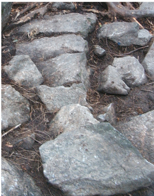
Ryc. 2. Ślęza 10, podwaliny budynku
