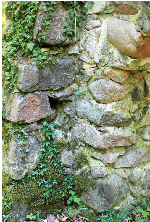
Abb. 5. Aussparung für einen Querbalken auf der Innenseite des Tors (Foto Verfasser)
