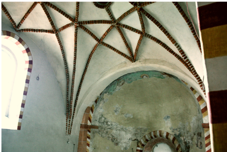
Ryc. 1. Strzelno, bazylika Świętej Trójcy – prezbiterium. Sklepienie i absyda – po bokach i wokół środkowego okna widoczne geometryczne polichromie, w głębi, na konsze absydy relikw figurальной polichromii. Fot. J. Struwe
