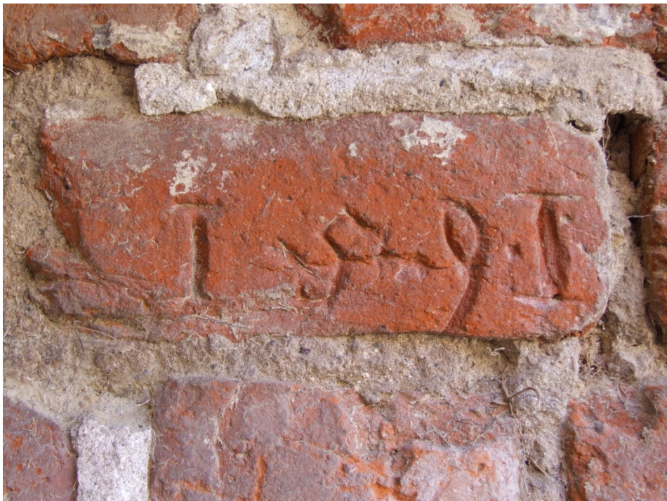
Ryc. 6. Kruszwica, stan. 2. Data 1591 wyryta na jednej ze ścian korytarza w pomieszczeniach piwnicznych „kamienicy” zamkowej. Fot. P. Pawlak
