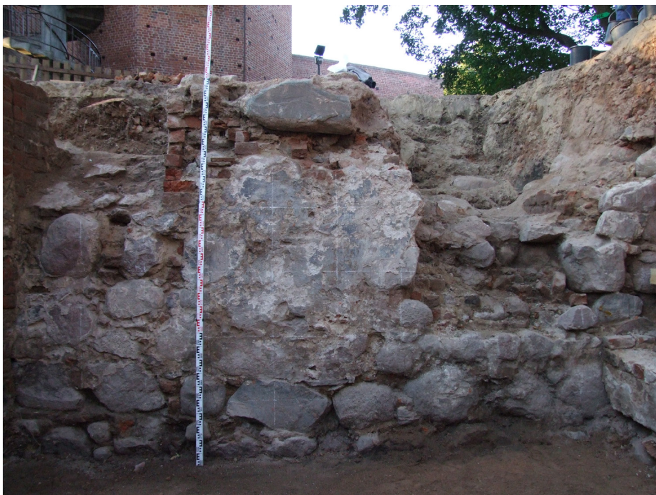
Ryc. 8. Kruszwica, stan. 2. Wykop XXXI, piwnica 1, ściana N, lico S. Zachowane dwa otwory okienne, jeden z nich (zachodni) z ceglany wykończeniem gładkim. Lico ściany pokryte tynkiem z ciemnoszarą monochromią. Fot. P. Pawlak
