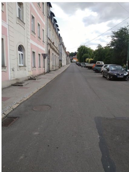
Fot. 5. Piława Górna. Ulica przy głównym placu, Plac Piastów Śląskich; brak oznakowania (fot. MK).
