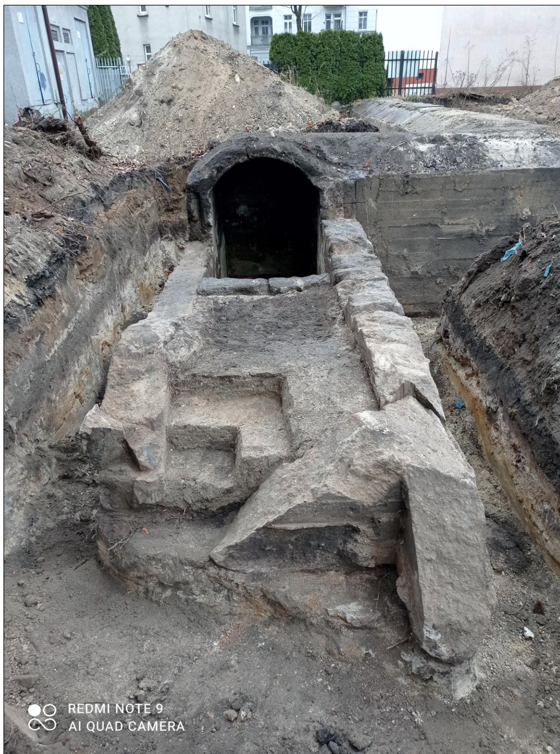
Ryc. 5. Poznań, ul. Kolejowa 50/52. Zejście do schronu od strony wschodniej. W prawym dolnym narożu zdjęcia widoczne dostawienie dwóch betonowych segmentów fundamentu budowli – ujęcie od E (fot. P. Banaszak).
