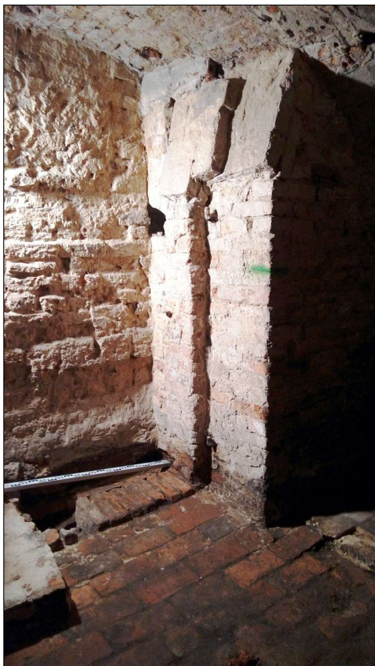
Ryc. 3. Poznań, ul. Żydowska 7. Relikt filara ceglanego z zaznaczonym węgiem otworu komunikacyjnego, oporem nadłucza i progiem wyjścia na podwórze wewnętrzne z pierwotnego zamknięcia tylnego założenia z końca 1. połowy XVI wieku (?) w pomieszczeniu 0.3 traktu tylnego kondygnacji piwnicznej kamienicy — ujęcie od NW (fot. P. Banaszak).
